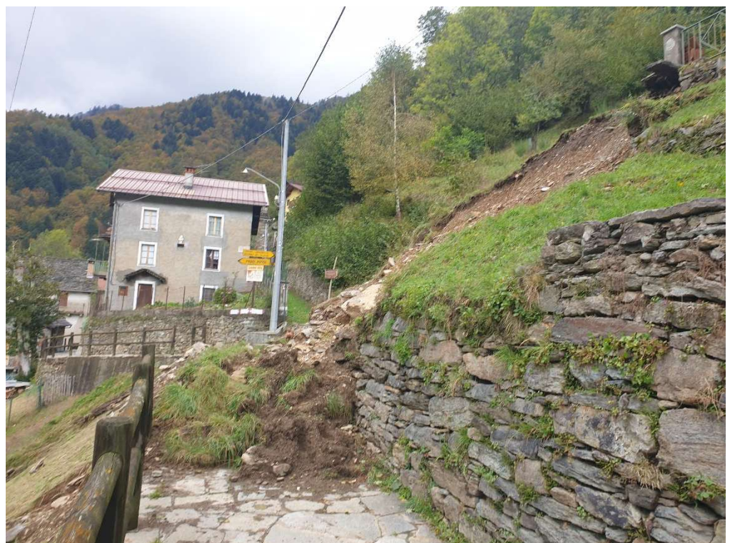
Immagine Alluvione Ottobre 2020 Erosione proveniente dall'impluvio a monte della strada
